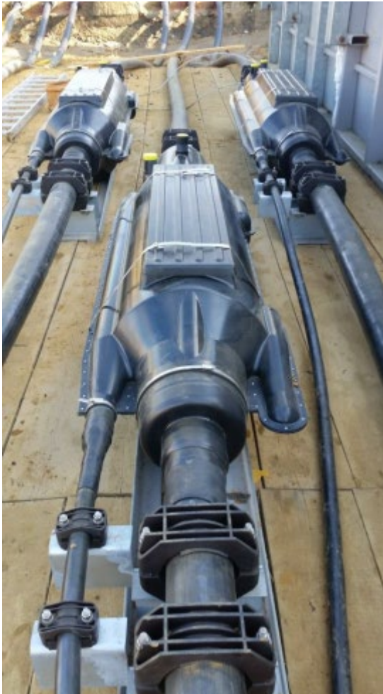
Abb. 3-4: Beispiel für eine Muffenverbindung
