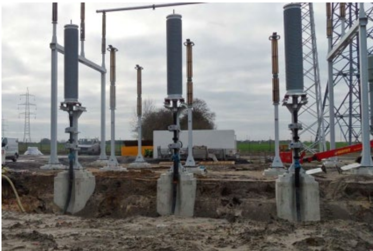
Abb. 3-5: Beispielhafte Darstellung dreier Kabelendverschlüsse
